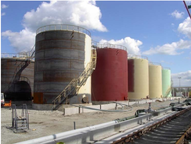
INERTA PRIMER 3 Epoxy Primer INERTA 51 Epoxy Intermediate INERTA 50 Epoxy Top Coat
